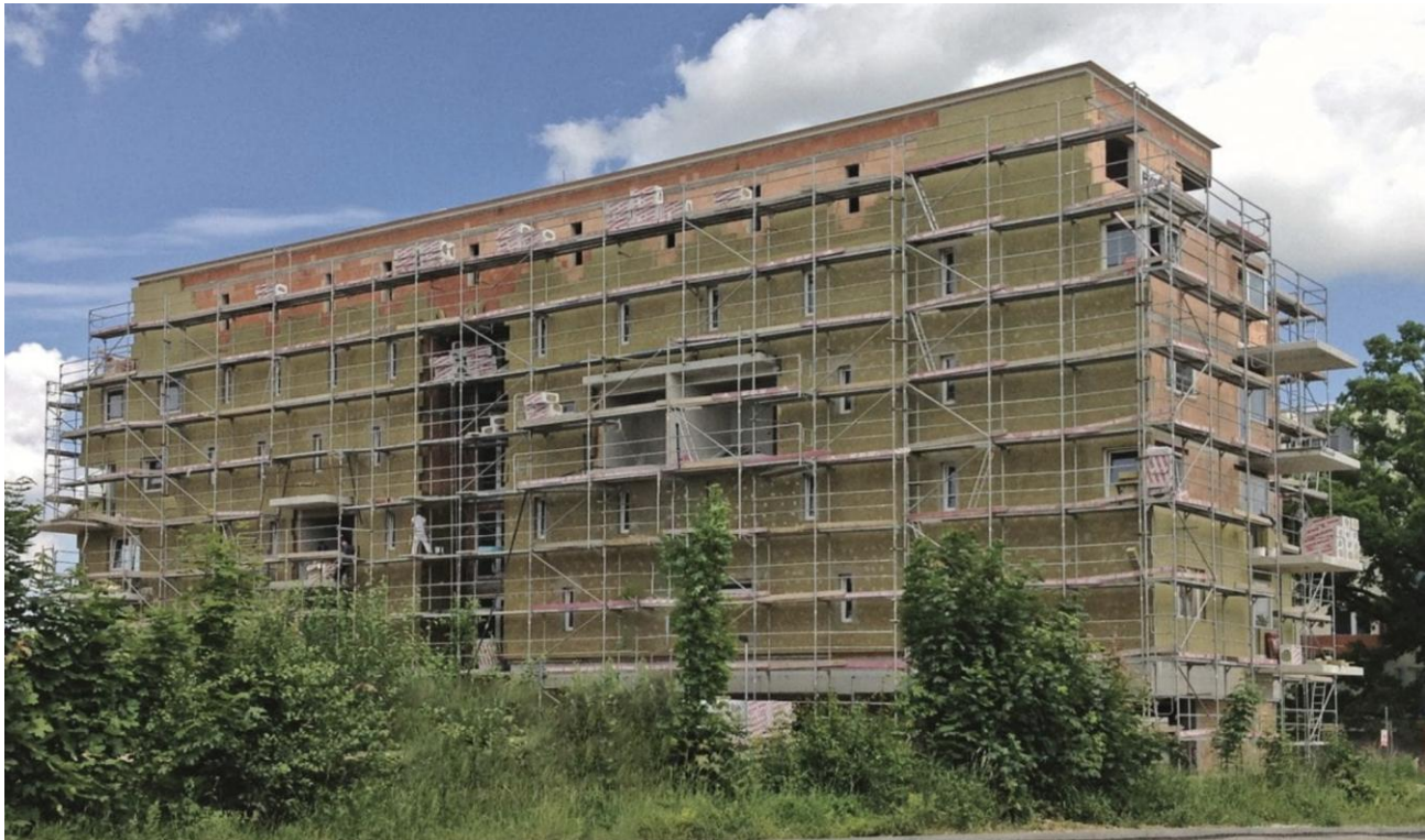
Obrázek 12 Ukázka zateplení fasády minerální vatou
