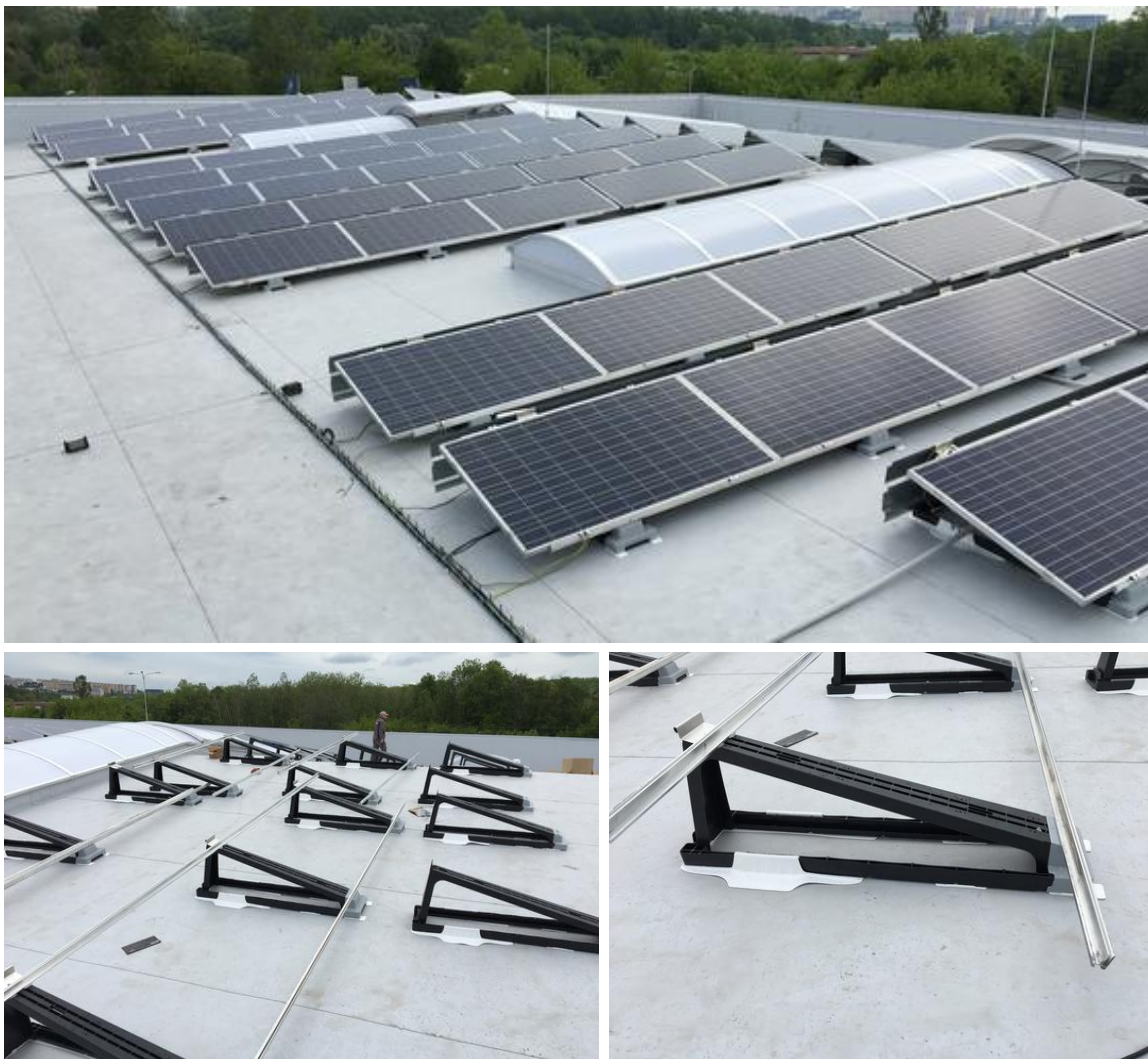
Obrázek 15 Instalace solárních panelů na ploché střeše
